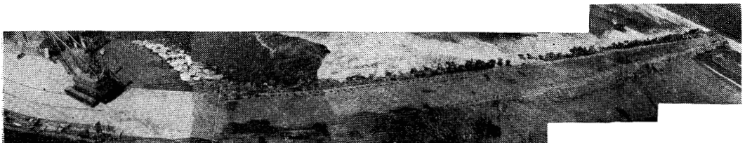
写真-4 防波堤進行状況
