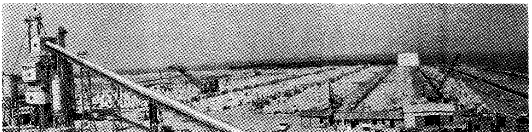
写真-8 ブロックヤード全景
