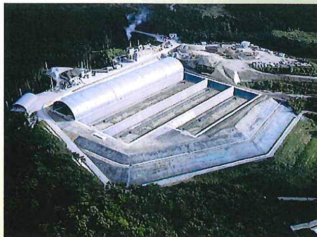
秋田県潟上市の移設型被覆施設管理型最終処分場の全景
