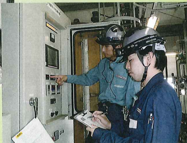
現場での巡回点検
